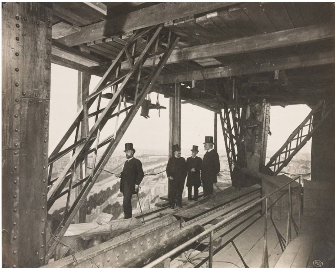
Anonyme (? - ?), Quatre hommes coiffés de haut-de-forme visitant le chantier de la Tour Eiffel, 1888, © Musée d'Orsay, Dist. RMN-Grand Palais / Patrice Schmidt (nota PP: Il primo uomo a sinistra è chiaramente Gustave Eiffel)
